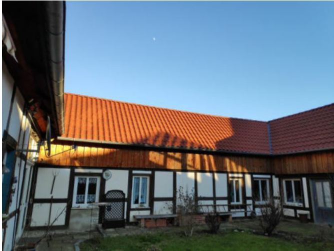
Stilvoller Anbau L-förmig
